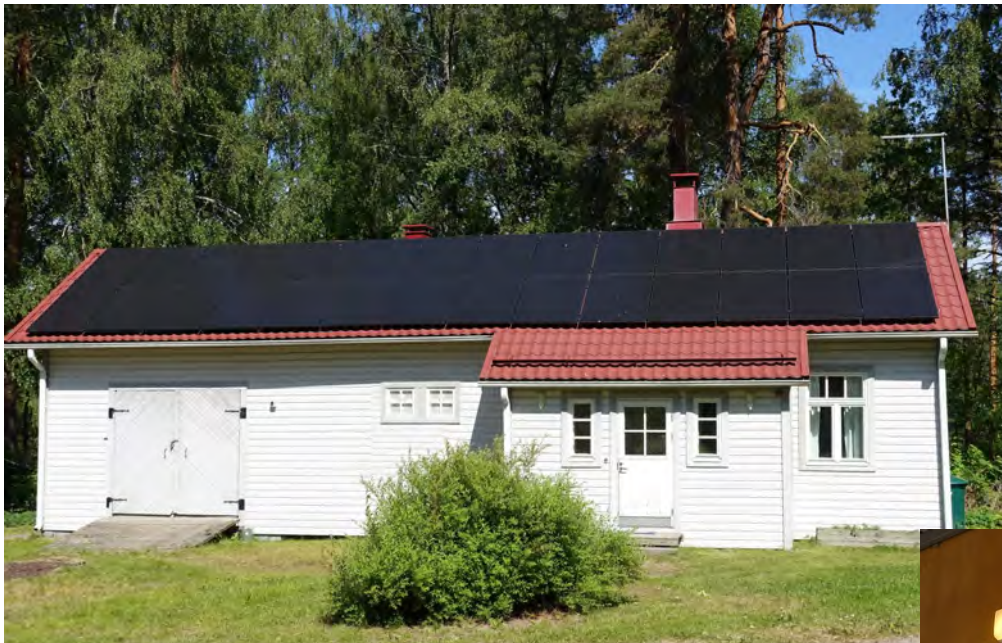
Aurinkopaneelit asennettiin Kesäharjuun
